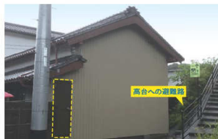
耐震改修と同時に高台への避難路に面して新たに屏が設けられた。
